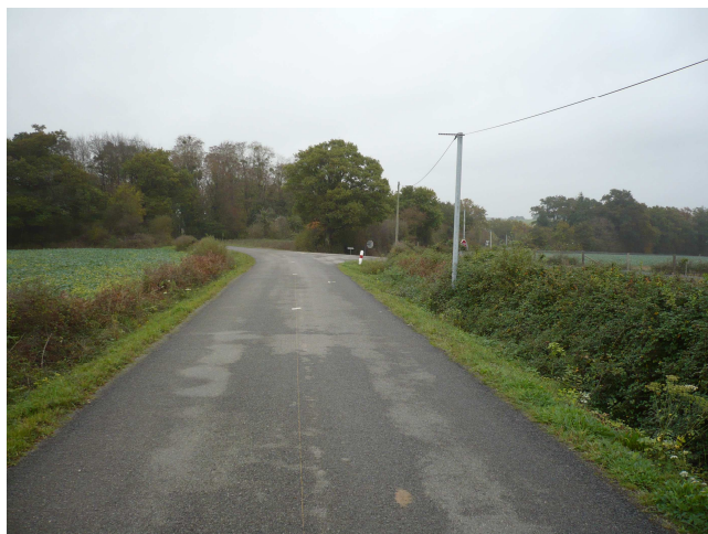
Vue de l'intersection précédente depuis la RD 41 Sud
