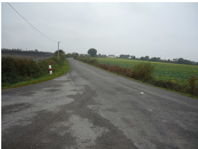
Vue de l'intersection des deux routes précédentes avec la RD 41 Sud
